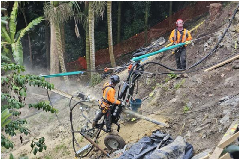
ABSEIL RIG DRILLING
